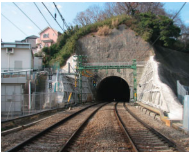
▲杉田駅～京急富岡駅間
